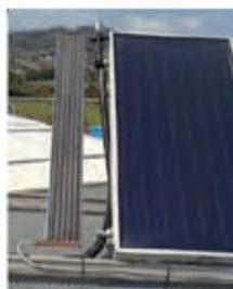
Ayuda y mejora en la eficiencia de la instalación: El funcionamiento del Disipasol se basa en el trabajo conjunto de una válvula termostática que empieza a abrir al llegar a la temperatura de 90°C para instalaciones convencionales, dejando circular el líquido caloportador a través del disipador estático. Este es el encargado de eliminar el exceso de calor de la instalación solar térmica
