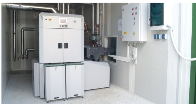
Vista interior del contenedor
