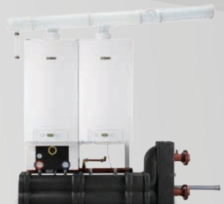
**Paso 3:** Colgar las calderas y conectar a la hidráulica mediante el grupo de bombeo
