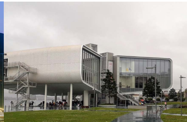
Centro Botín - santander Renzo Piano & Luis Vidal + arquitectos Clima Canal
